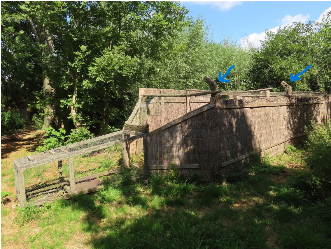
Eén van de vangarmen van de eendenkooi. Bij de pijltjes zijn de betonnen palen uit de WO II
